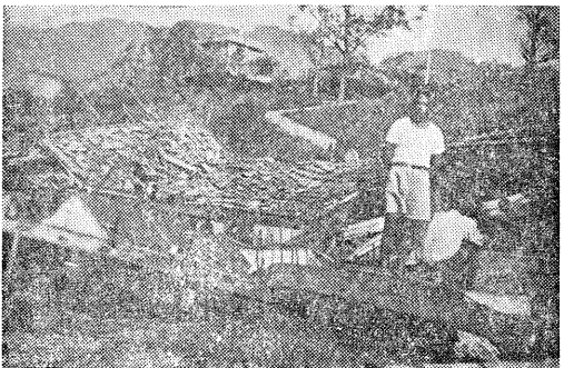
磚牆建築的鐵工廠吹倒
