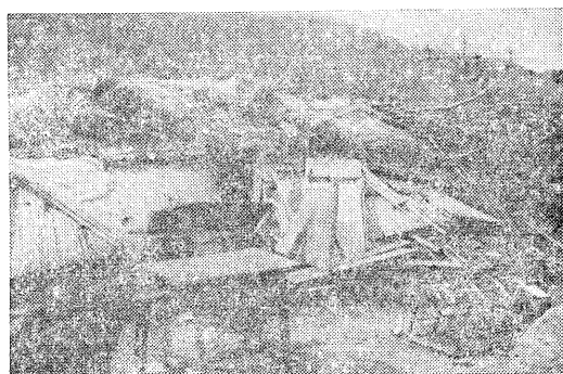
三間之民房吹倒
