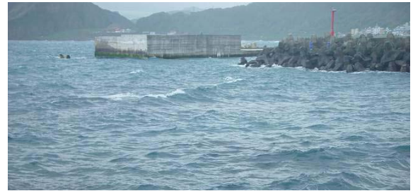
圖16 基隆長潭漁港潮境公園遠處外堤
