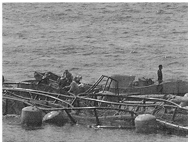
圖 8、錨碇系統崩潰造成整組箱網攪在一起 (2005 年屏東小琉球海流流速暴增之流失事件)
