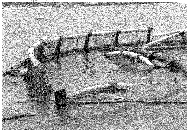
圖 9、浮框變形折斷 (2005 年海棠風災屏東小琉球)
